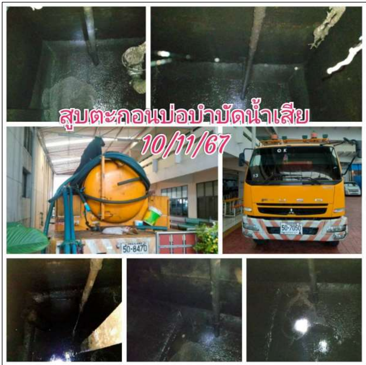
รูปที่ 20 (ต่อ) การขุดลอกท่อระบายน้ำ และสูบลตะกอนโดยรอบโครงการ
