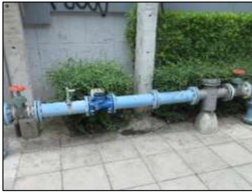
รูปที่ 25 มิเตอร์น้ำของโครงการ
