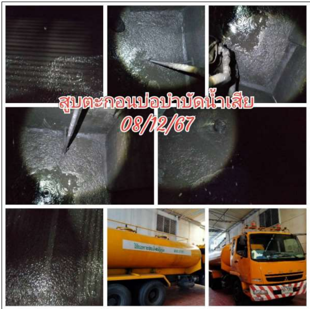
รูปที่ 20 การขุดลอกที่ระบายน้ำ และสับตะกอนโดยรอบโครงการ
