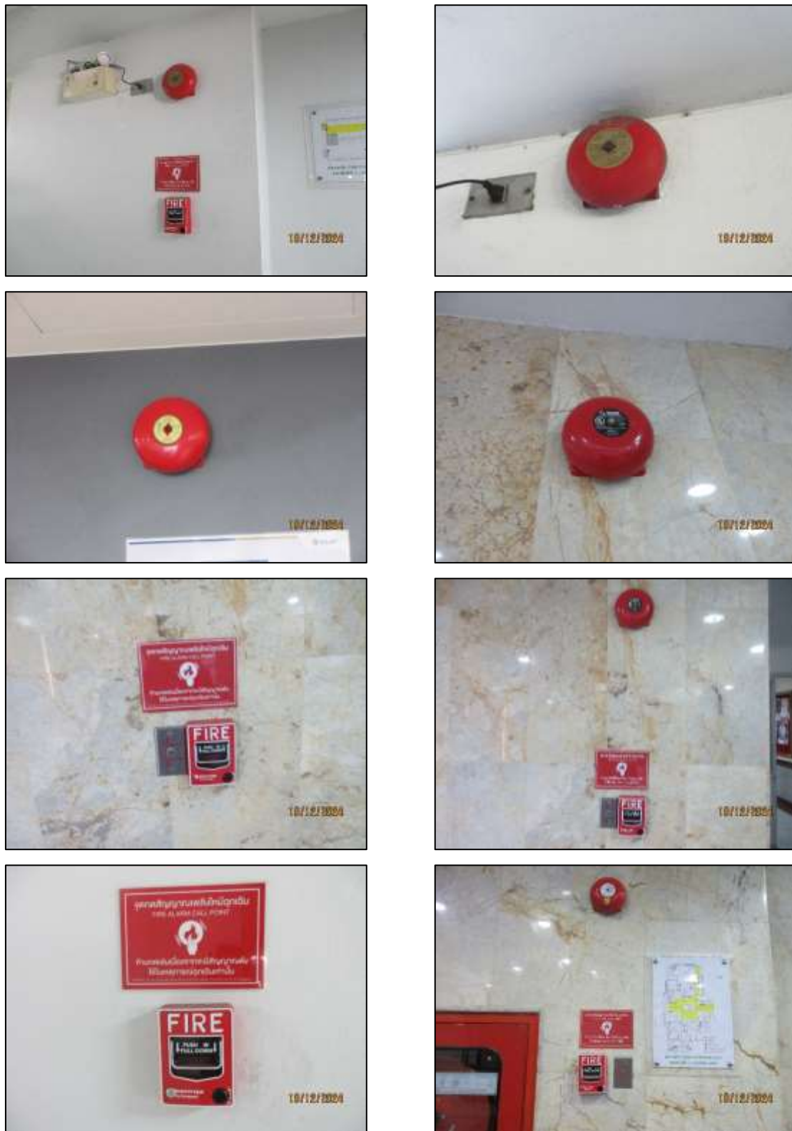
รูปที่ 44 (ต่อ) อุปกรณ์แจ้งเหตุเตือนเพลิงไหม้
